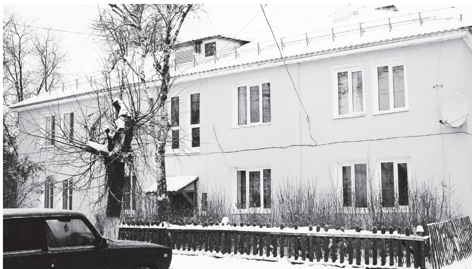
▲ Так сейчас выглядит один из первых отремонтированных домов по ул. 1 Мая
