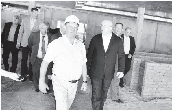
▲ В здании будущего Ледового дворца
