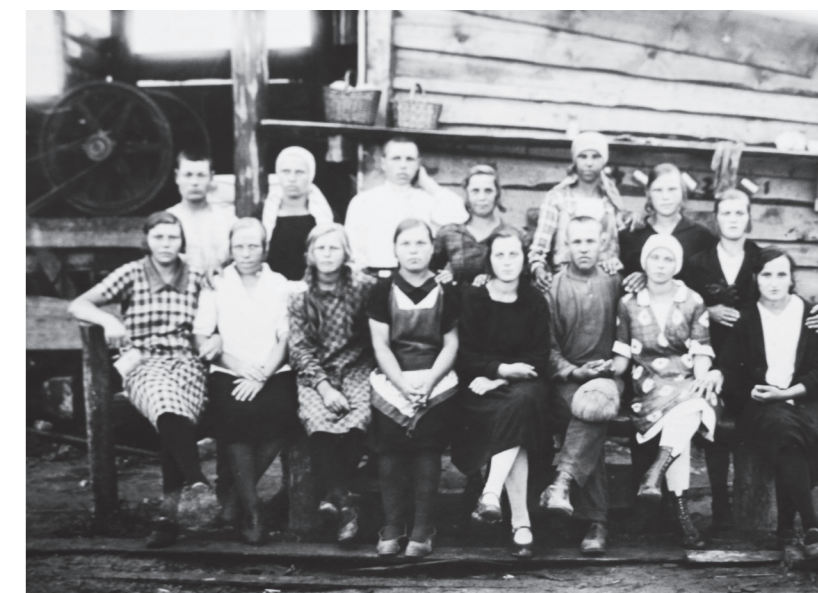
▲ Девушки на строительстве первых двухэтажных домов в п.Мордовщицево на ул.Ленина, 1926 год
