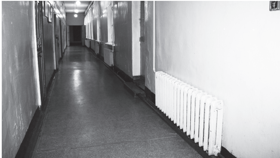
▲ Проведен текущий ремонт систем отопления в образовательных учреждениях
