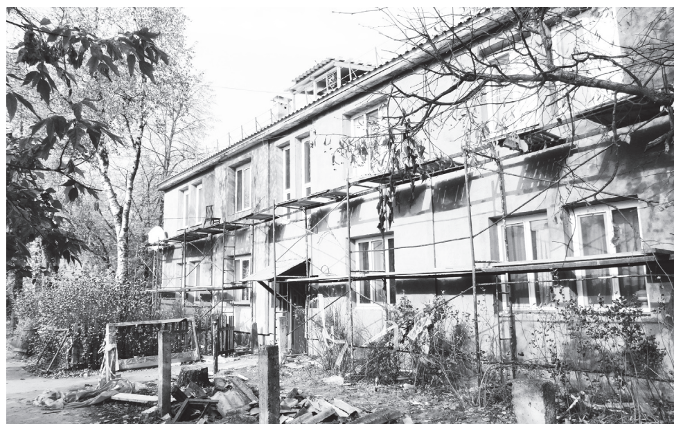
▲ Активно идет капитальный ремонт домов по ул. 1 Мая
