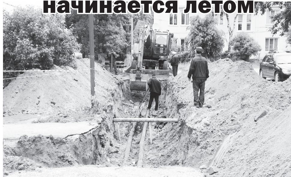
▲ Работа по замене 336 метров трубопровода тепловой сети в разгаре
