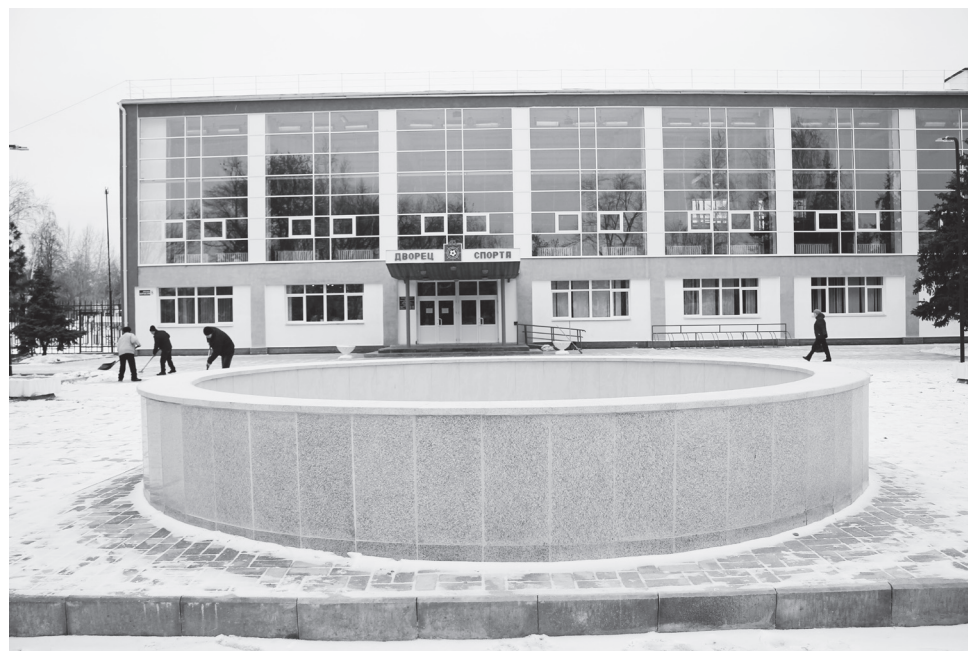
▲ Фонтан после ремонта
