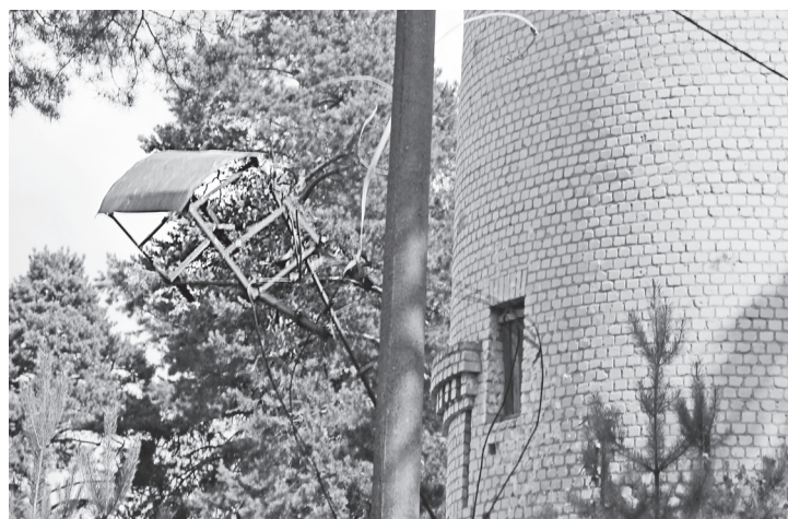
▲ Металлоконструкция падает вниз по заданной траектории
