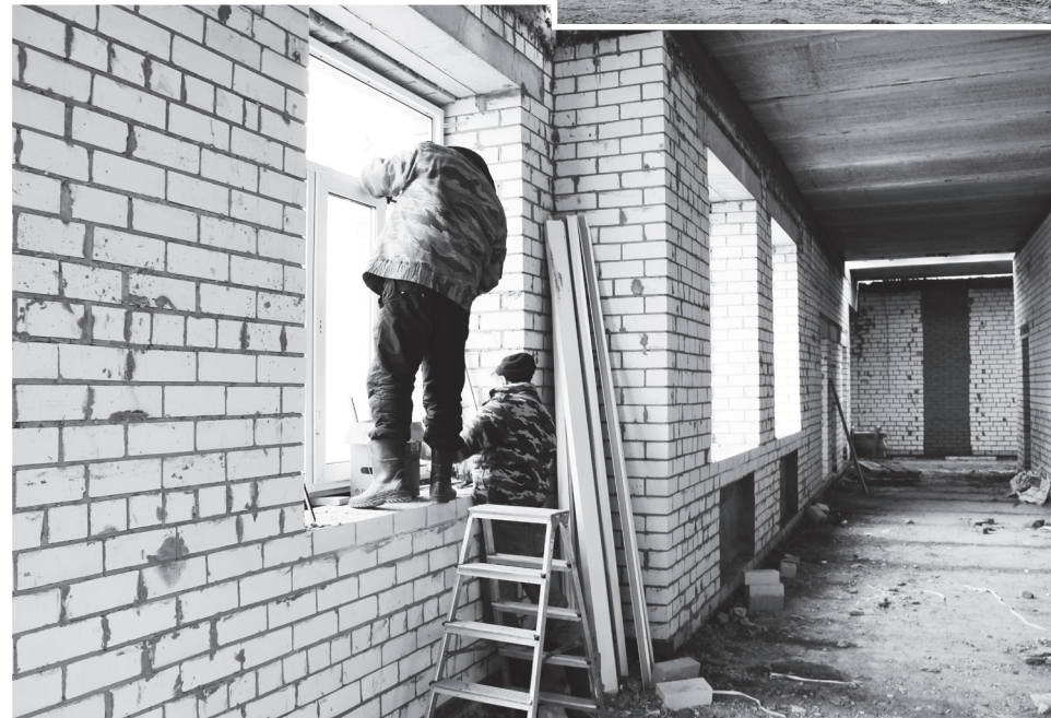
▲ На первом этаже уже завершена установка стеклопакетов
