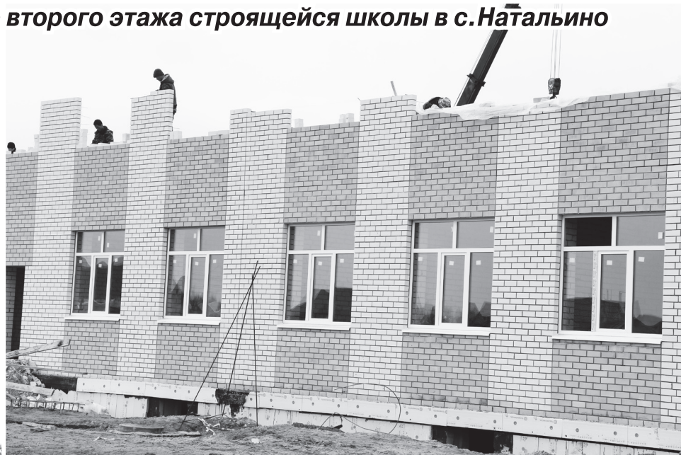
▲ Перекрытие 2-го этажа будет выполнено в этом месяце
